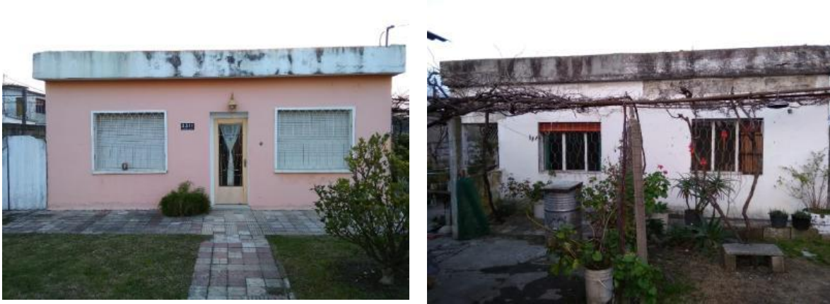
Figura 3-5. Fachada principal y posterior
