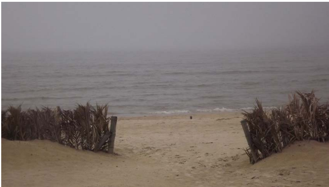
Figura 63. Fotografía de cercos vegetales para la retención de arena en playa Pocitos, Montevideo. Elaboración propia (2015).
