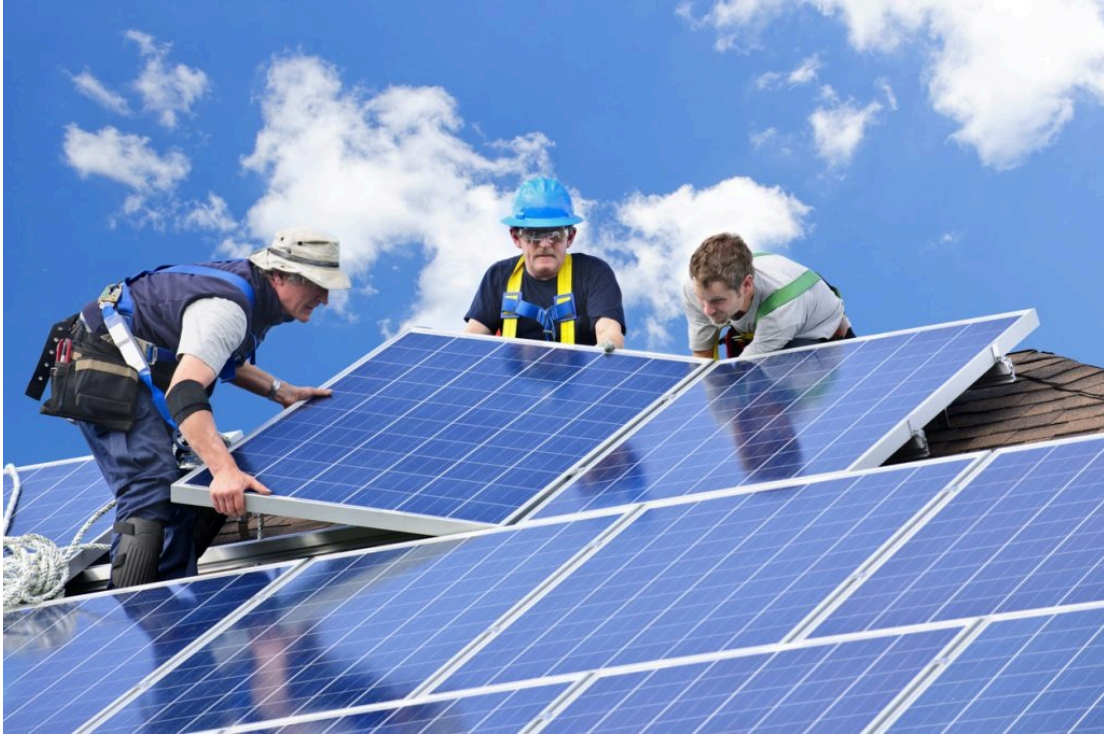
Figura 6.3 | Ejemplo de puesta en obra de paneles
